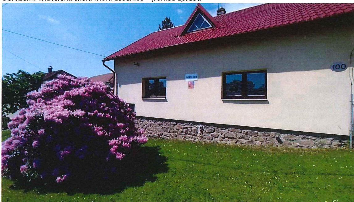
Obrázek 7 Mateřská škola Malá Losenice – pohled z předu
